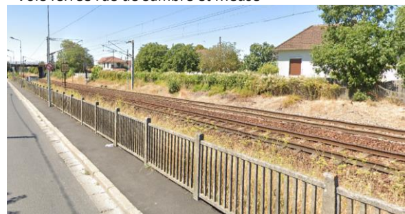
Voie ferrée rue de Sambre et Meuse
