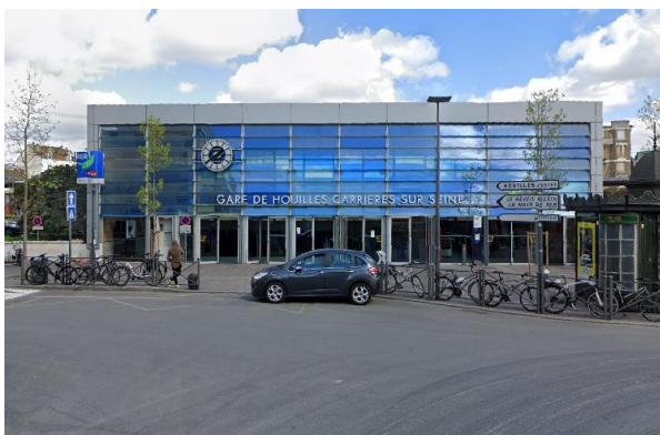
Gare de Houilles / Carrières-sur-Seine
