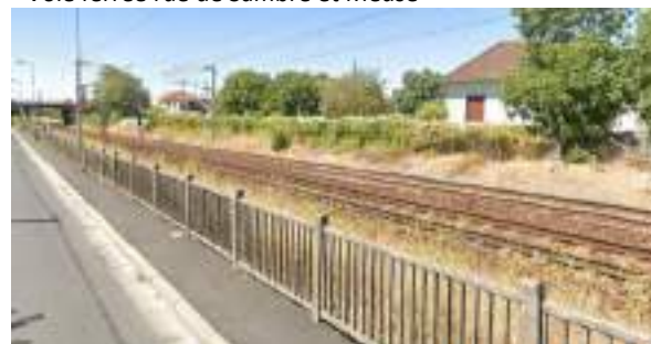
Voie ferrée rue de Sambre et Meuse
