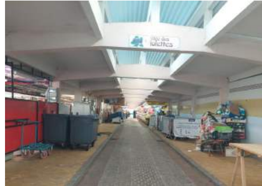
Stockage déchets dans la surface de vente
