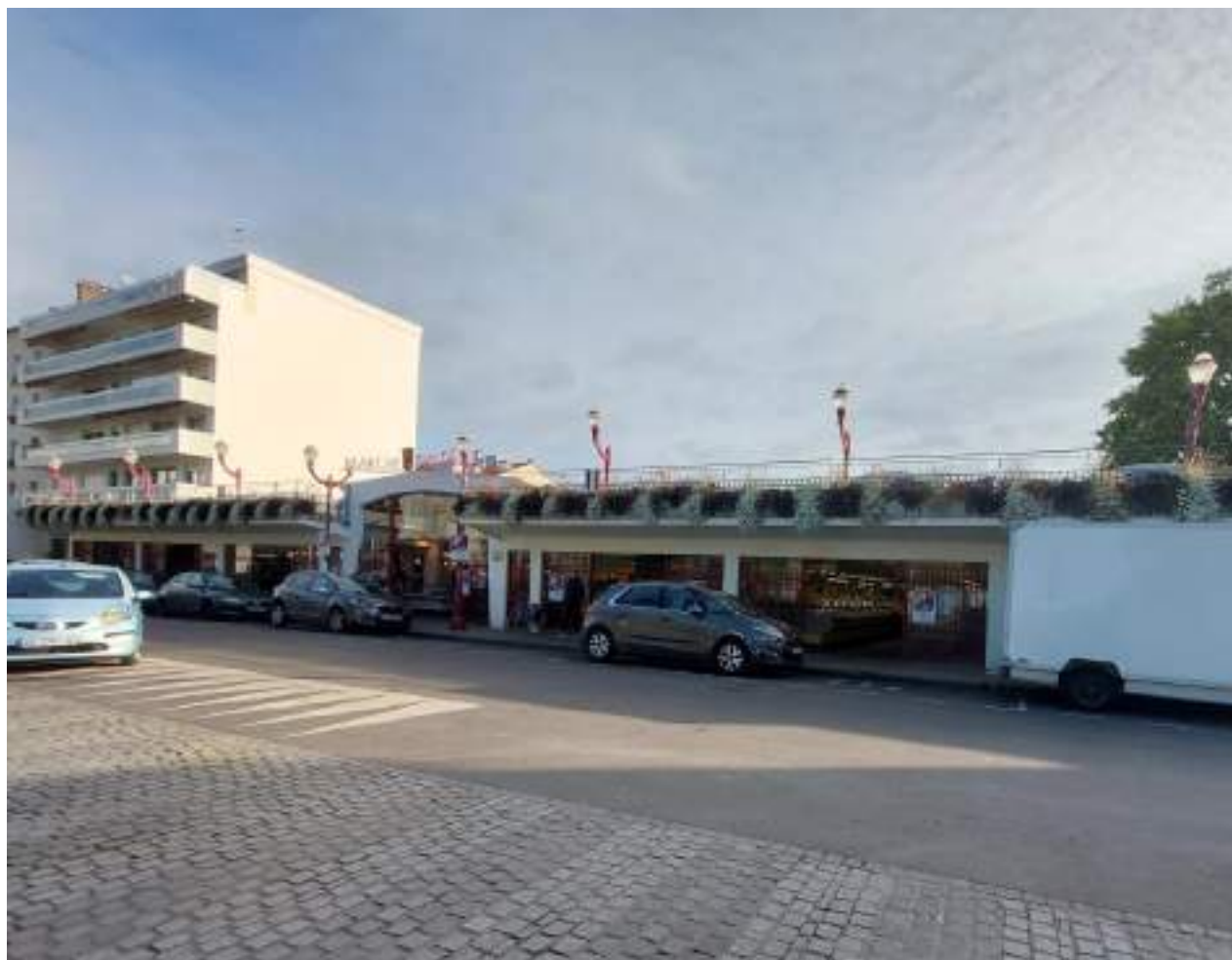
La faible hauteur de l'édifice marché couvert s'efface derrière les véhicules et le sol à l'aspect exclusivement routier
