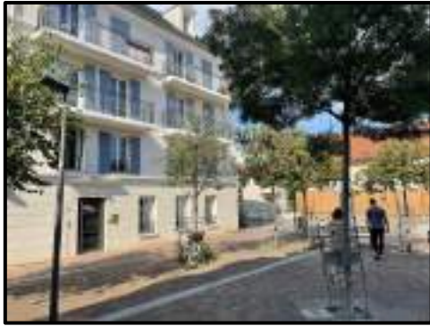
ZAC de l'Église : 680 logements (2005-2017)
