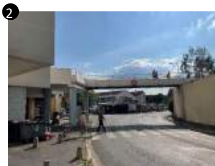
Passerelle surplombant la rue de la Marne
