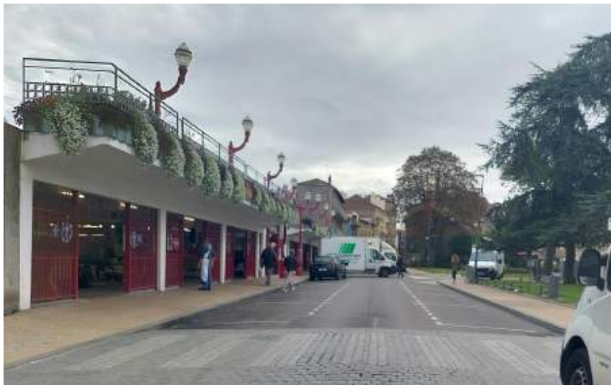
Rue Gambetta, faible impact de la façade dans l'atmosphère de parc, aucun parvis ne matérialise un espace piéton
