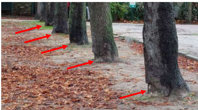
Plaies au collet des marronniers derrière le monument aux morts
