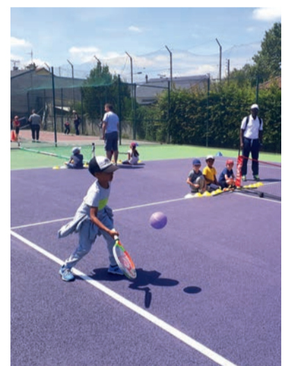
Rénovation des terrains de tennis au stade Maurice-Baquet.
