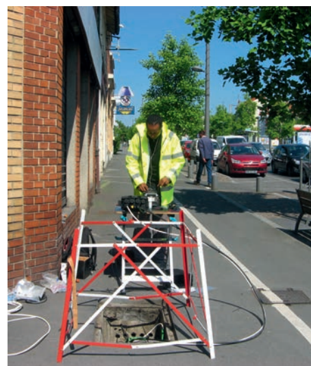
Déploiement de la fibre optique boulevard Henri-Barbusse.
