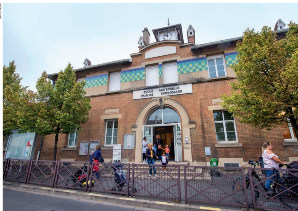
Rénovation du groupe scolaire Buisson-Bréjeat-Kergomard : 2,50 M€.
