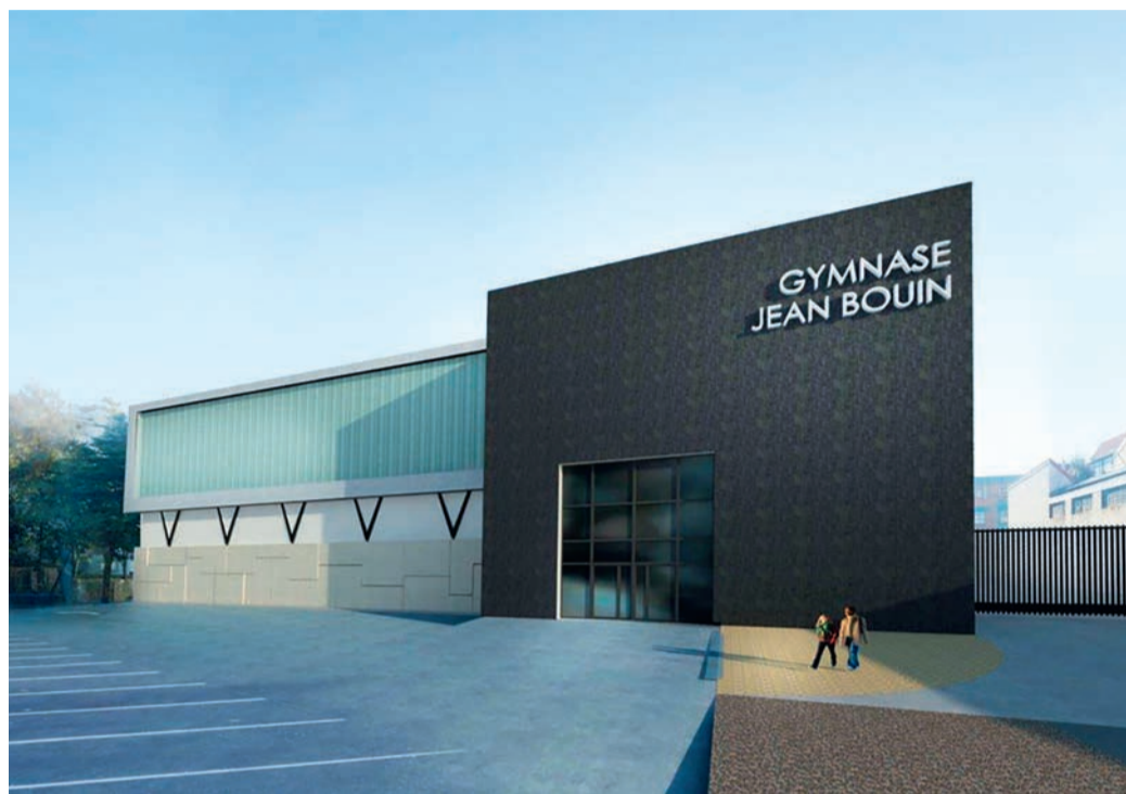
Projet de réhabilitation du gymnase Jean-Bouin : 3,20 M€.
