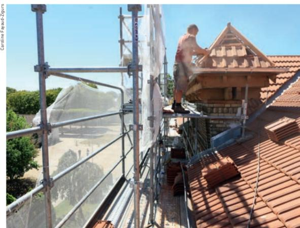
Réfection complète de la toiture de l'école Jules-Guesde, comprenant le remplacement des tuiles et des liteaux ainsi que la rénovation de l'isolation.
