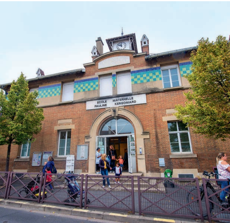
Rénovation du groupe scolaire Buisson-Bréjeat-Kergomard : 3,10 M€.
