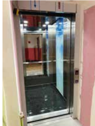
— La pose d'un ascenseur rend l'école Jean-Détraves accessible aux personnes à mobilité réduite.
