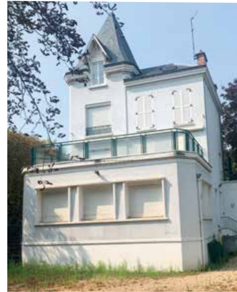
Le pavillon de l'ancienne crèche Charles-de-Gaulle.
